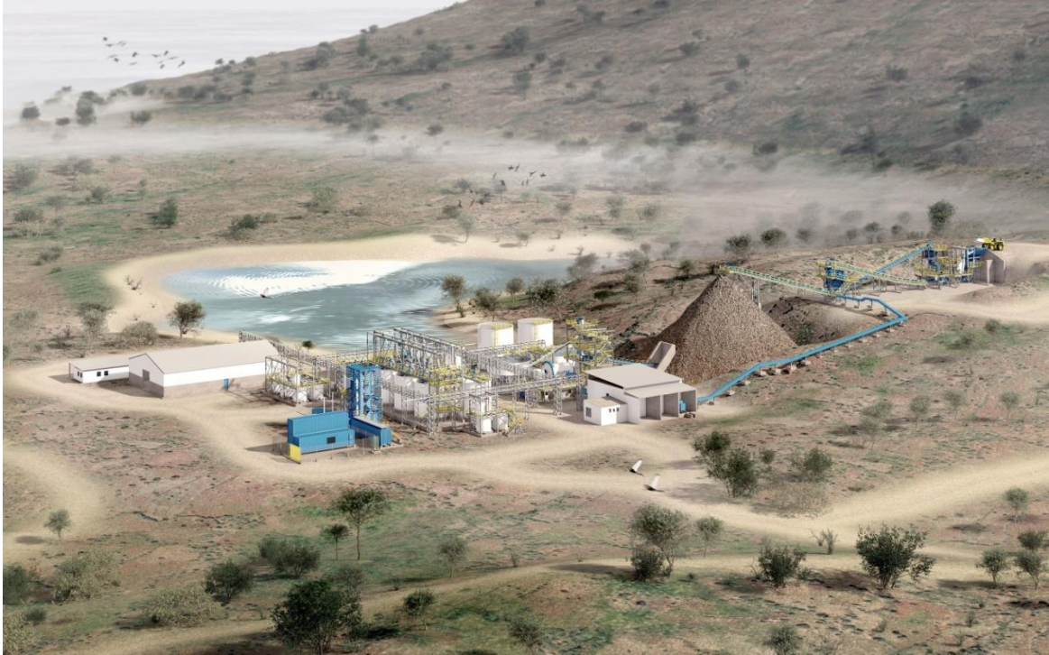
Schlüsselfertige Golderaufbereitungsanlage mit einer Produktionsleistung von 35 tph in Äthiopien
