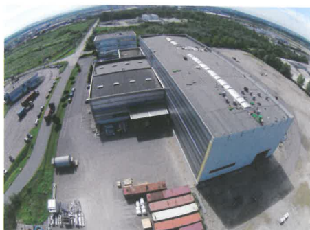
CEMTEC Halle Ennshafen
