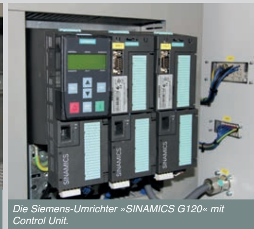
Über die neuen kleinen kompakten Klemmen »ET 200SP«, die über Profinet angebunden sind, werden die Umrichter angesprochen.
